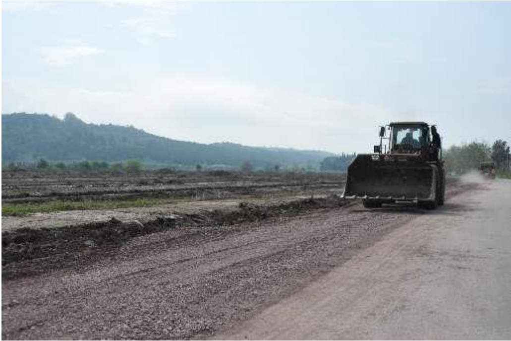
Şekil 6 Yalova Garden A. Ş.'de başlayan altyapı çalışmalarından bir görünüm
